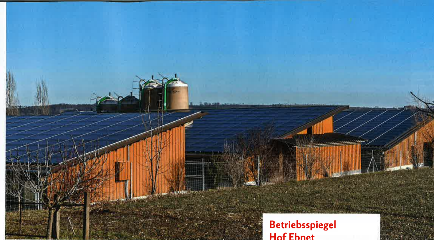
Der dreiteilige Schweinestall auf dem Hof Ebnet besteht aus einem Abferkel-, einem Aufzucht- und einem Maststall (von links nach rechts).
